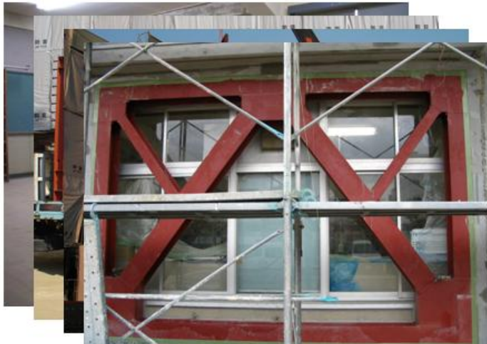
斜め材(筋交い)設置工事
