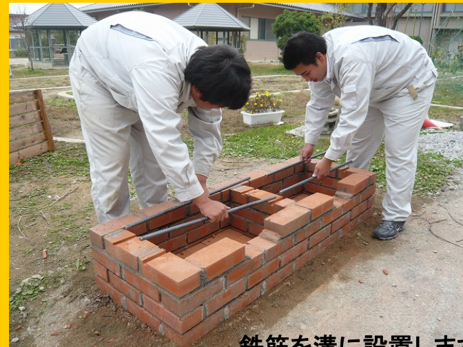
鉄筋を溝に設置します
