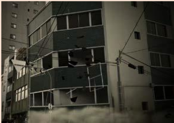
強い揺れによる建物崩壊
