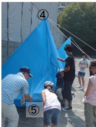
(5) 物干し竿を立上げ、形を整えながら ⑤をペグで固定、同時にロープを2本張る。
