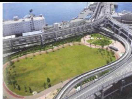
④ 震災の教訓を生かし、防災設備を備えた「みなとのもり公園(神戸震災復興記念公園)」(兵庫県神戸市)
