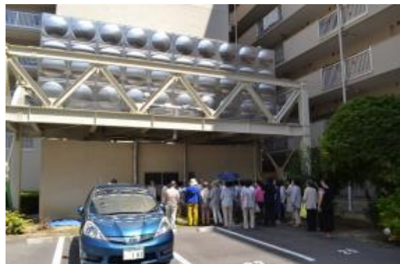
水タンクの停電時給水方法も確認
