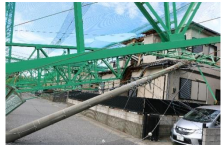
写真 電柱の被害状況(千葉県)
