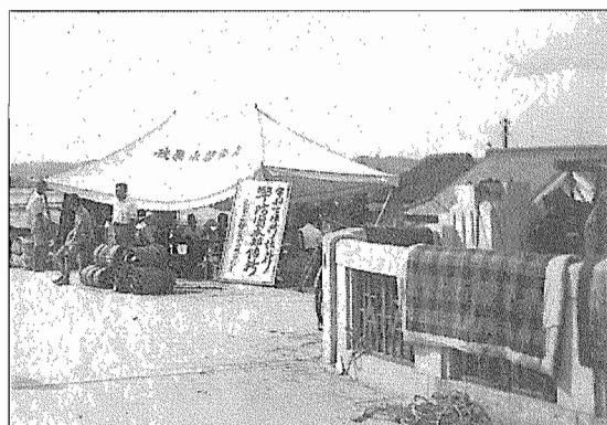
厚東川大橋西詰宇部市警防団詰所
