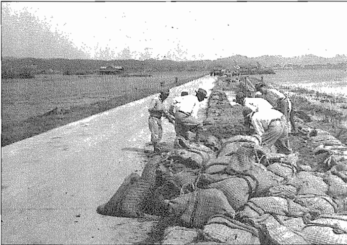
西割産業道路（現 190 号線）仮堤防工事
