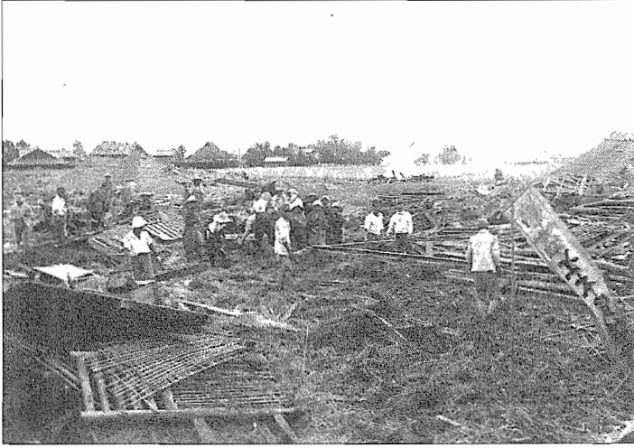
塩屋台付近で流出家屋の後片付け
