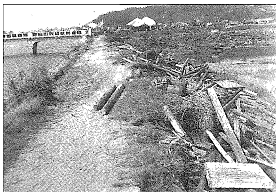
厚東川大橋東岸（居能側堤防）
