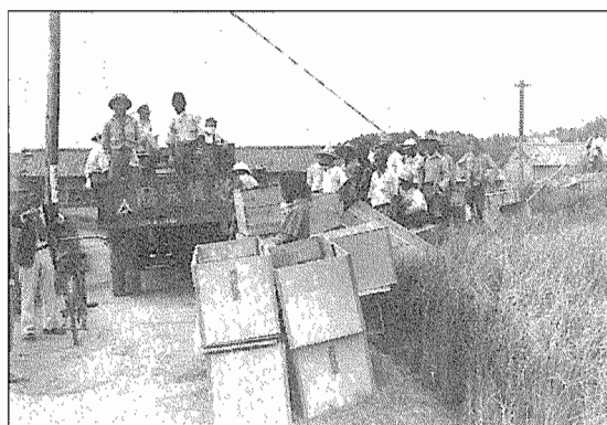
犠牲者の収容作業
