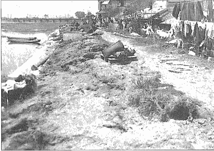
厚東川旧橋（琴川橋）付近
