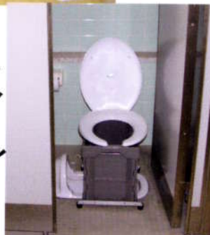
← 和式トイレ に簡易トイレを 設置した例 →
